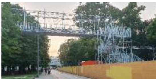
Baubeihilfsüberbrückung an der Neuen Pinakothek
