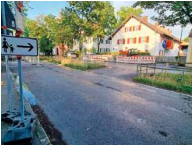
Fußgänger sollen wegen einer Baustelle die andere Straßenseite benutzen, auf der sich ebenfalls eine Baustelle befindet.
